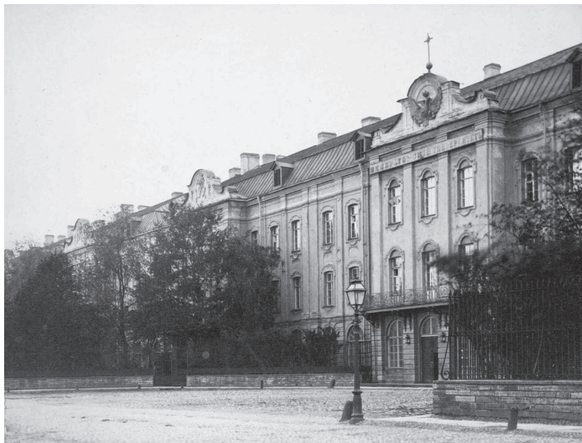
Главный вход в здание Императорского Санкт-Петербургского университета. 1880 г. Музей-архив Д. И. Менделеева
