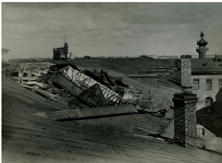
Рис. 3. Крыша ЗИН АН СССР после бомбежки 23 августа 1943 г. НА ЗИН РАН Fig. 3. The roof of the Zoological Institute after the bombing on August 23, 1943. Scientific Archive of the ZIN RAS
