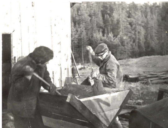
Рис. 12. Морская биологическая станция ЛГУ на о. Среднем, Белое море. Научные сотрудники В.И. Ефремов и В.В. Кучко перемешивают песчано-цементную смесь для заливки фундамента. 1977 г.
