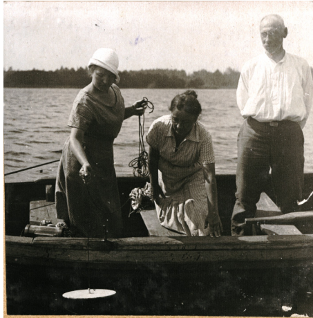
Рис. 10. Измерение прозрачности воды диском Секки на Пустыньских озерах. НБ МГУ ОРП. Ф. 48. Оп. 1. Ед. хр. 54. Л. 11
