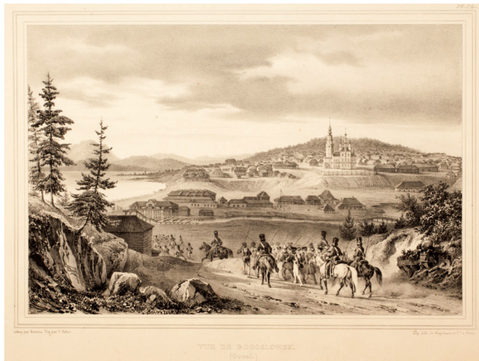
Рис. 2. Вид Богословского завода. 1828.
